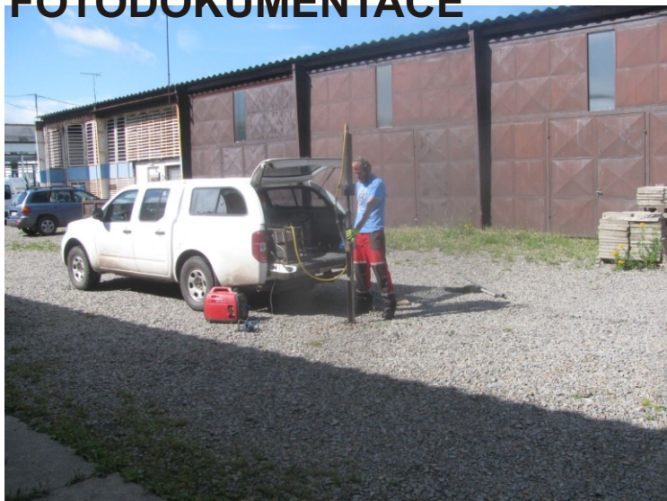
Foto 1, 2 : realizace průzkumných sond
